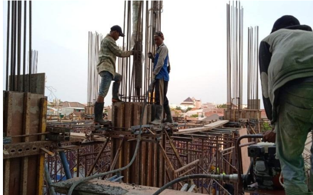
Gambar 4.4. Pengecoran kolom
