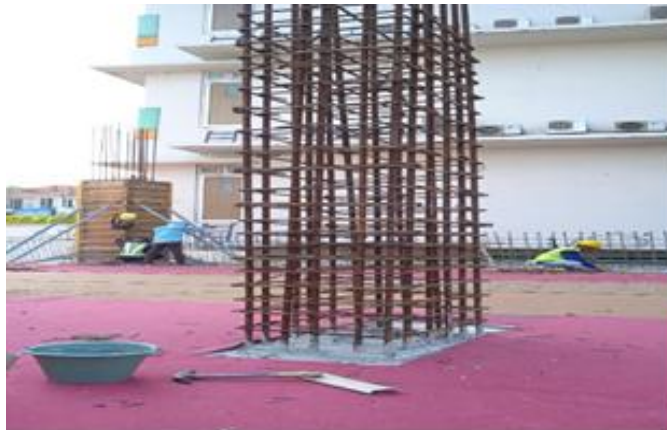
Gambar 4.2. Penulangan kolom
