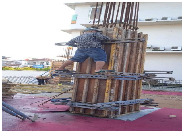
Gambar 4.3. Pemasangan bekisting
