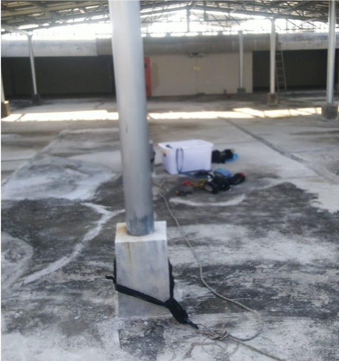
Lampiran Pemasangan anchor untuk tali kerja dan persiapan pembersihan kaca
