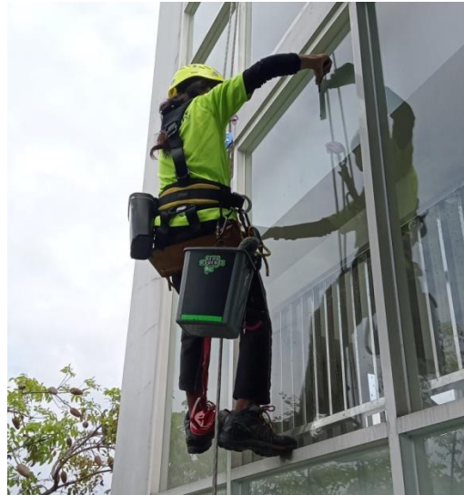
Gambar 2. 16 Pekerjaan Naik Melalui Tali Pendahulu Sumber : Gambar Dokumentasi Peneliti, 2022
