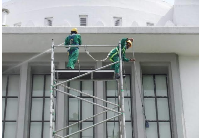
Gambar 2. 20 Menggunakan Metode scaffolding Sumber: www.gbf.word , pembersih kaca gedung, 2021
