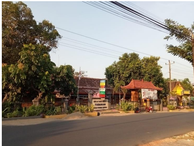
Gambar 4.3. Gedung SD Negeri 01 Todanan
