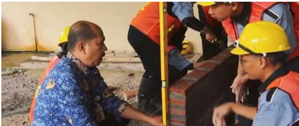
Gambar 4.7 Guru kejuruan Teknik konstruksi perumahan memberikan penjelasan langsung Teknik-teknik pemasangan batu bata harus memperhatikan akurasi ukurannya.(O.5)
