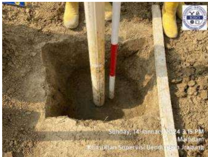
Gambar 4. 10 Pengecekan Koordinat dan Elevasi Sebelum Pemasangan Plat Magnet (Sumber : Data Proyek Bendungan Jragung, 2024)
