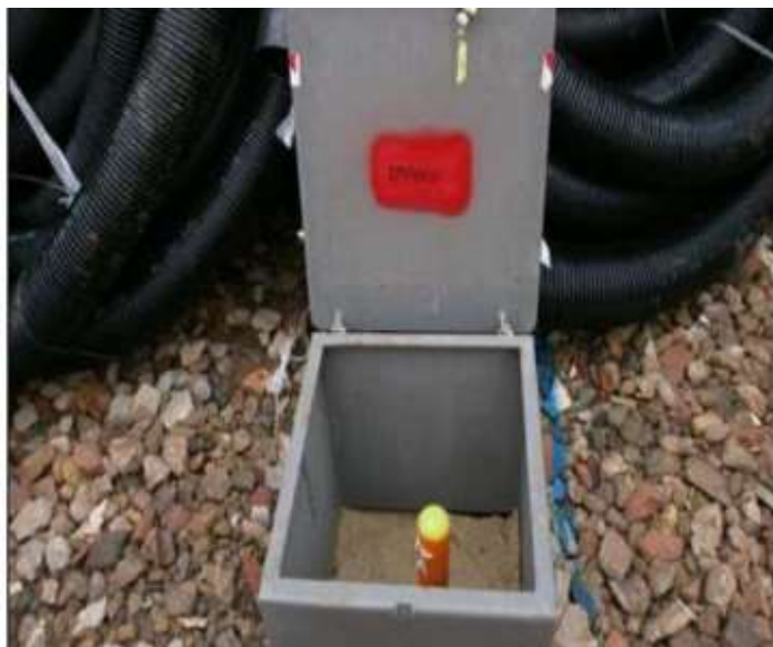
Gambar 4. 15 Pengamanan Lokasi Pemasangan Selama Pekerjaan Timbunan (Sumber : Data Proyek Bendungan Jragung, 2023)
