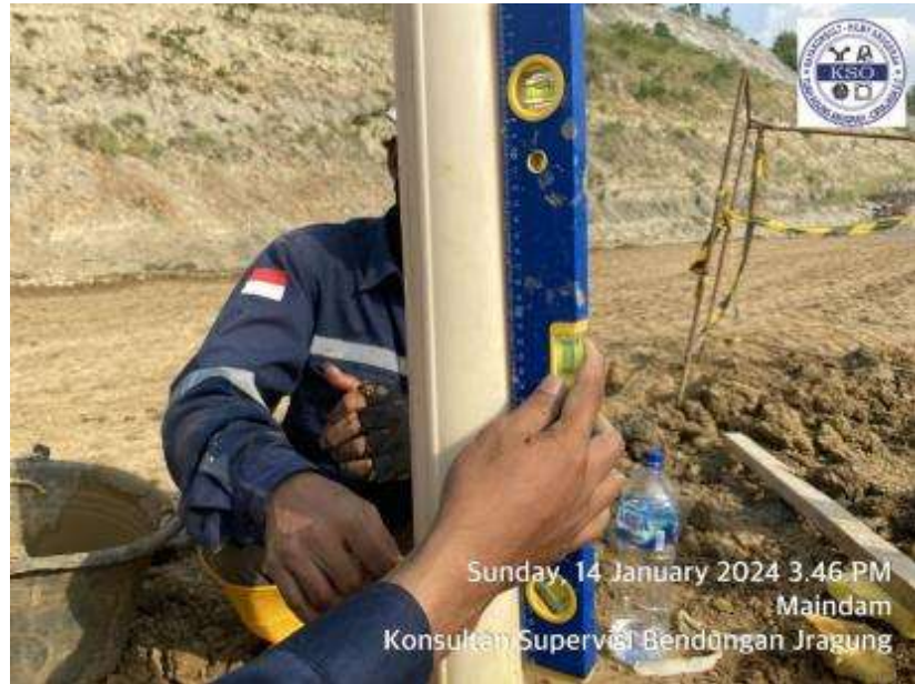
Gambar 4. 12 Pengecekan Ketegakan Pipa Inclinometer (Sumber : Data Proyek Bendungan Jragung, 2024)
