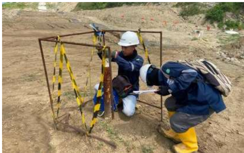
Gambar 4. 14 Pengecekan Ekstensometer/Inclinometer Selama Pekerjaan Timbunan
