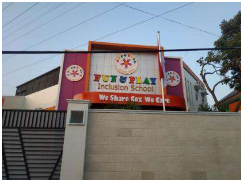
Gambar Gedung baru
